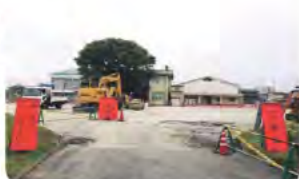
↑校舎解体工事後
