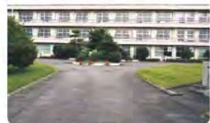
↑校舎解体工事前
